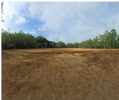
รูปที่ 2-18 ถมบ่อเก็บโคลนและปรับสภาพพื้นที่
