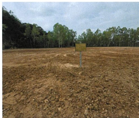
รูปที่ 2-18 ถมบ่อเก็บโคลนและปรับสภาพพื้นที่
