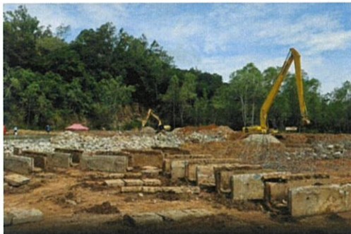
รูปที่ 2-11 รื้อวัสดุรองพื้นหลุมและถมหลุมให้เรียบร้อย
