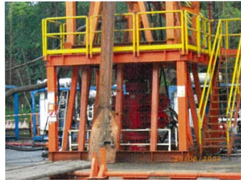
รูปที่ 2-30 ติดตั้งชุดอุปกรณ์ป้องกันการพลุ่ง (BOP) และ Shear Ram
